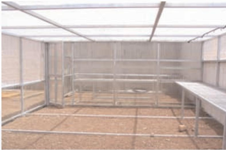
cogollos al final de la floración. Para las cortinas y el techo se usa un alambre del 14, y para el anclaje del invernadero se requiere uno más grueso, del N° 8 ó el 10.
